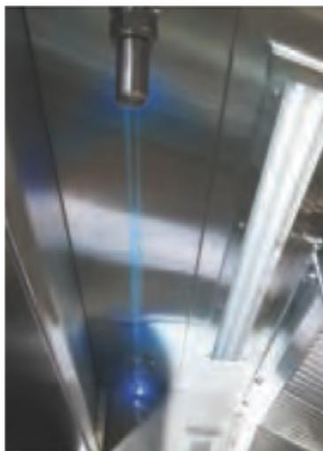
L'**automate CONCEPT AZUR** permet une régulation affinée de la ventilation grâce à la précision unique de « **l'Iris Bleu** » : capteur optique de variation d'opacité des vapeurs et fumées.
