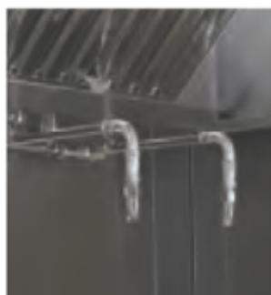
Des buses **disposées sur 3 niveaux (au-dessus des appareils de cuisson, dans les capteurs et les conduits d'extraction)**, assurent ensemble une décharge totale et continue de l'agent extincteur lors du déclenchement du système.
